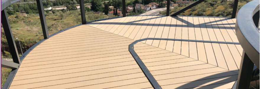
Tarima en pasarelas Decking on catwalks
