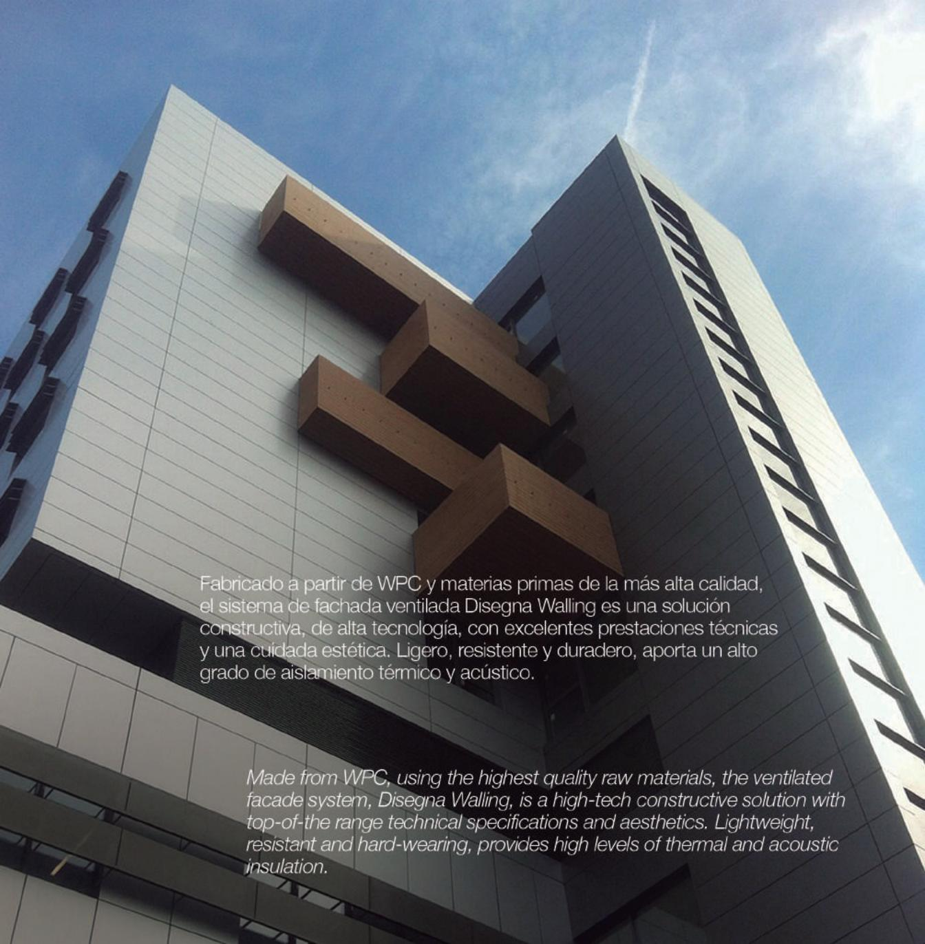
Fabricado a partir de WPC y materias primas de la más alta calidad, el sistema de fachada ventilada Disegna Walling es una solución constructiva, de alta tecnología, con excelentes prestaciones técnicas y una cuidada estética. Ligero, resistente y duradero, aporta un alto grado de aislamiento térmico y acústico.
